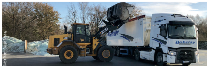
L'organisation met spécifiquement à disposition des installateurs un rack ou une benne, puis un camion plateau avec chariot embarqué pour collecter les déchets acheminés vers l'unité de démantèlement du PVC, aluminium, bois et vitrage, stockés sur une plateforme de 1 000 m 2 ; envoyés dans les centres de recyclage spécialisés, ils seront réintroduits dans de nouveaux process de fabrication d'Atlantem Industries, de FenêtrÉA et Riou Glass
