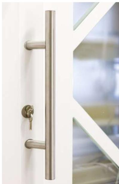
Barre de tirage inclinée vers l'int. 500 mm impliquant une serrure 4 galets avec manœuvre à la clé.
